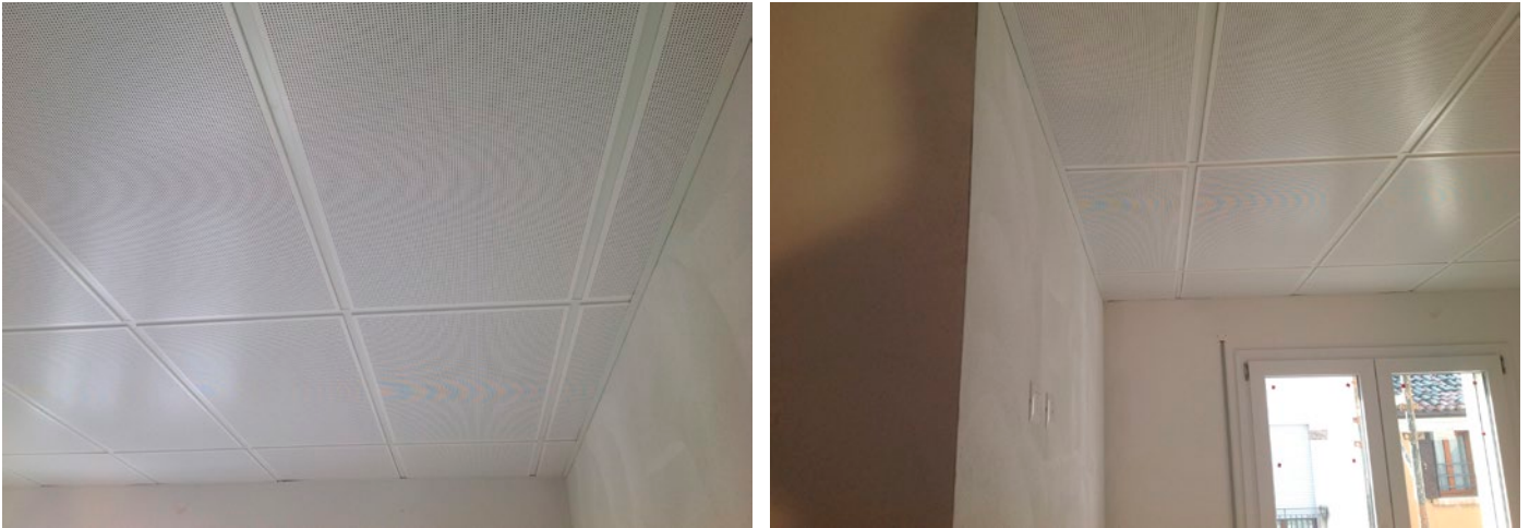
Figura 7. Dettaglio sistema radiante a soffitto (Fonte: Fraccaro Officine Termotecniche)
