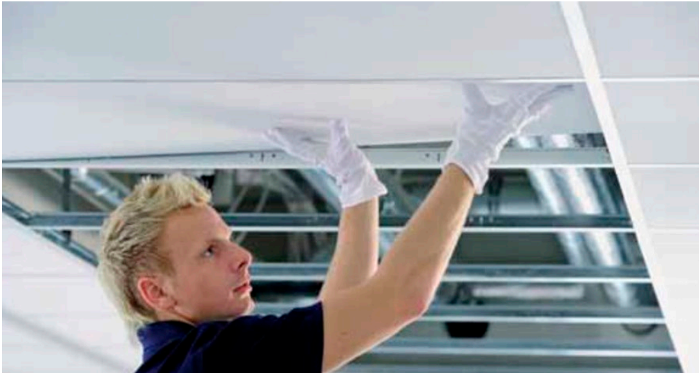
Figura 1. Esempio installazione controsoffitto radiante (Fonte: Uponor)
