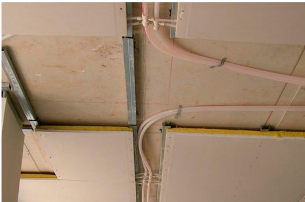
Figura 3. Sistema radiante a soffitto (Fonte: Eurotherm)
