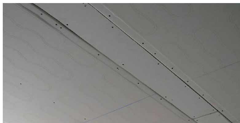
Figura 4. Sistema radiante a soffitto (Fonte: Eurotherm)
