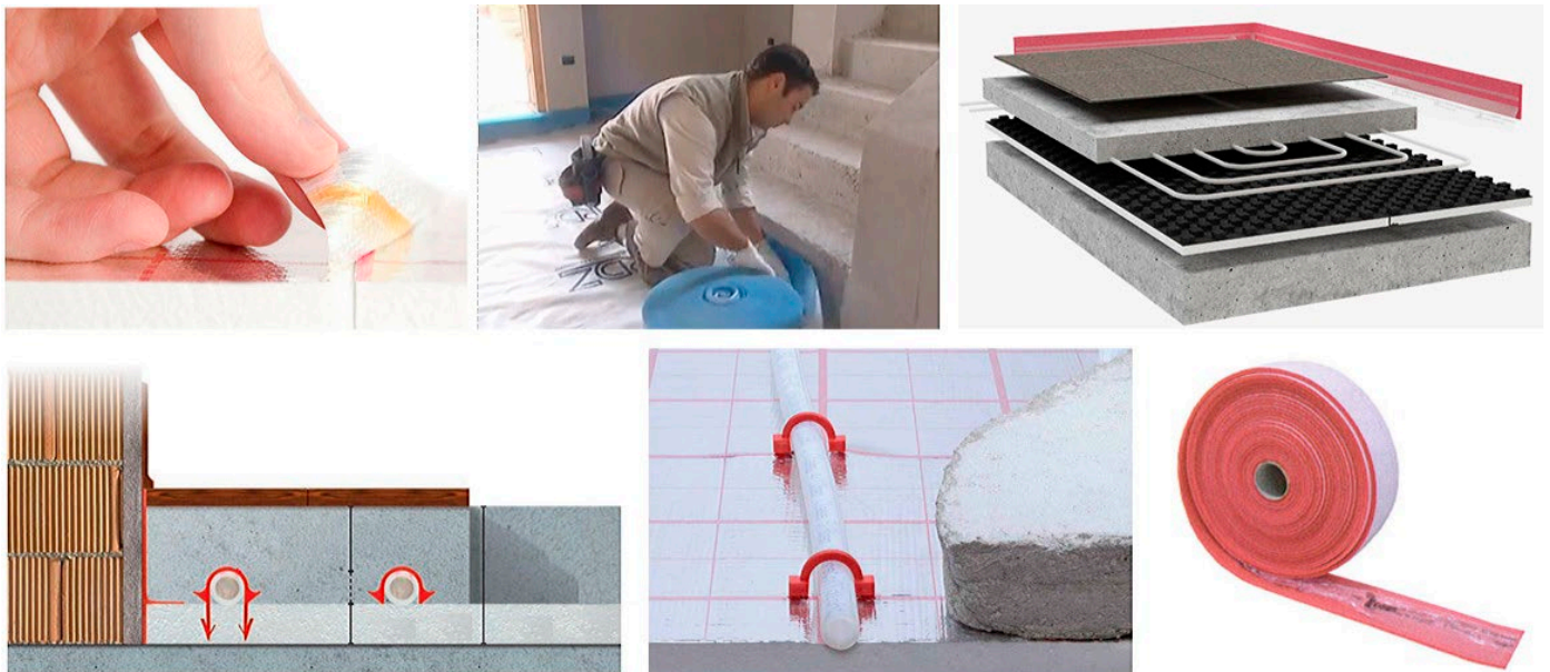
Installazione di sistema radiante a pavimento. Fonte: Aziende Consorzio Q-RAD
