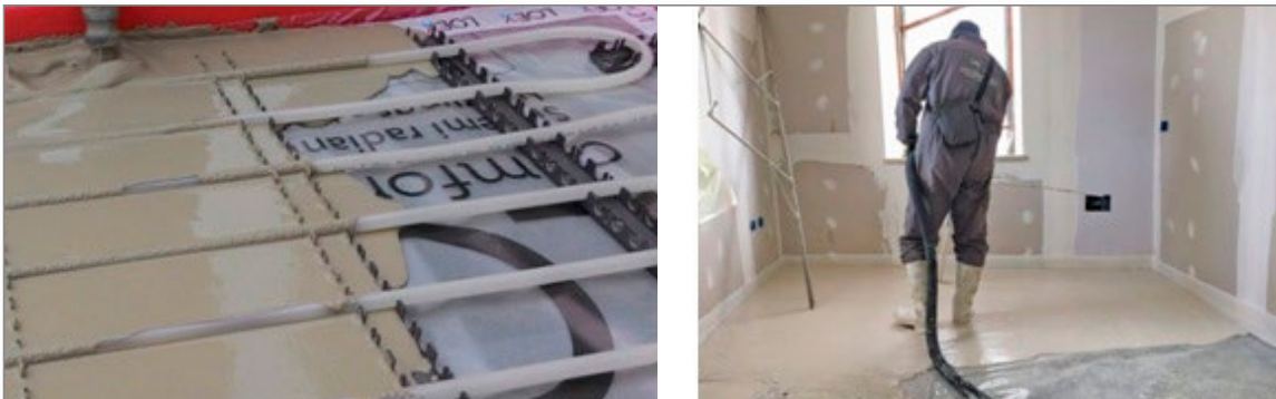
Installazione strato di supporto su sistema radiante a pavimento. Fonte: LOEX (a sinistra) e Eurotherm (a destra)
