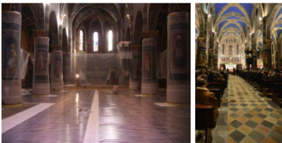
Figura 4. Duomo di Pinerolo. Ristrutturazione 2012-13. Installazione sistema radiante a pavimento a basso spessore, pavimentazione in quarzite. Fonte: LOEX
